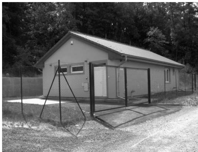
Čistírna odpadních vod Předměřice nad Jizerou
