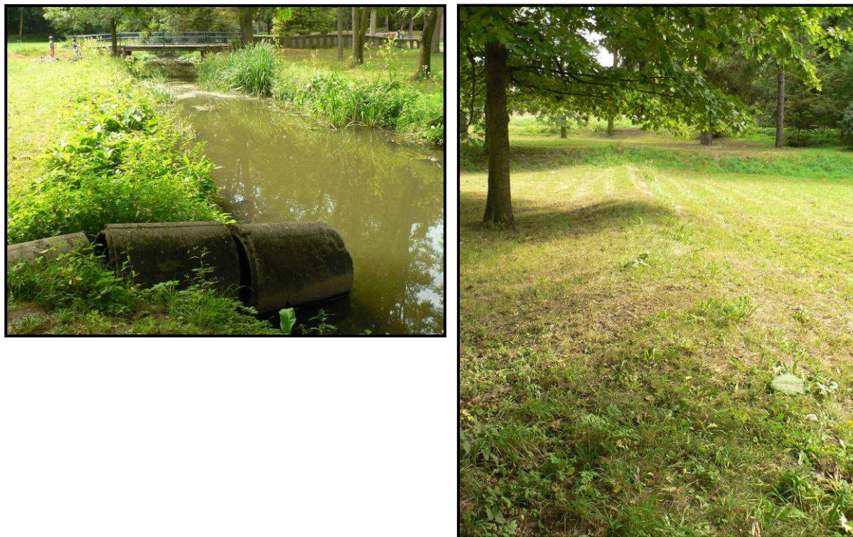
Obrázek č. 5: Stávající dešťová kanalizace svedená do vodoteče Klenice
