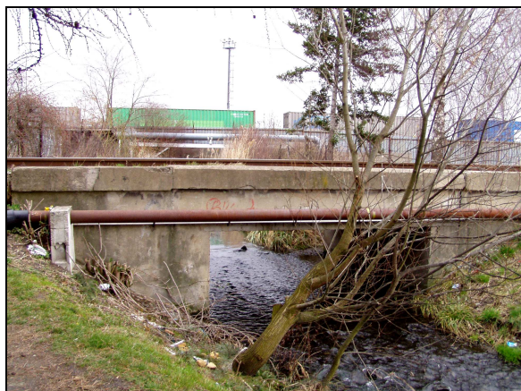
Obr. č. 12 Propustek Zalužanské vodoteče
