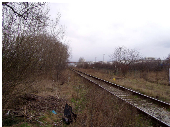
Obr. č. 10 vegetace drážního tělesa a jeho okolí
