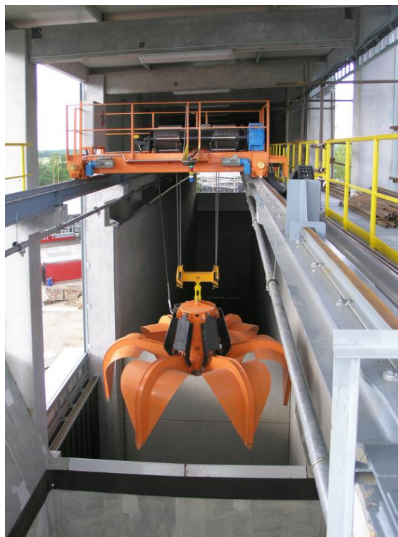
Obrázek 25: Automatický jeřáb s drapákem
