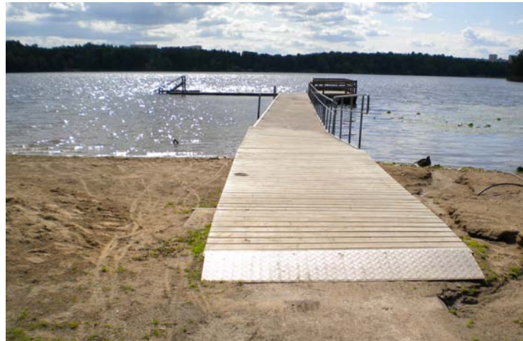
Bezbariérový přístup na molo
