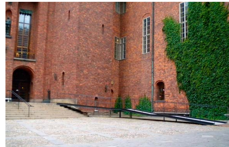
Subtilní rampa zajišťuje bezbariérový přístup do historické budovy
