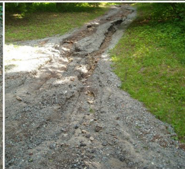
2013/ foto stávajícího stavu_wc, cesty
