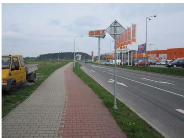
Přístupová komunikace - ulice Na Radouči, pohled k S
