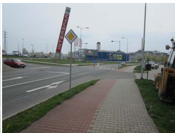
Přístupová komunikace - ulice Na Radouči, pohled k J
