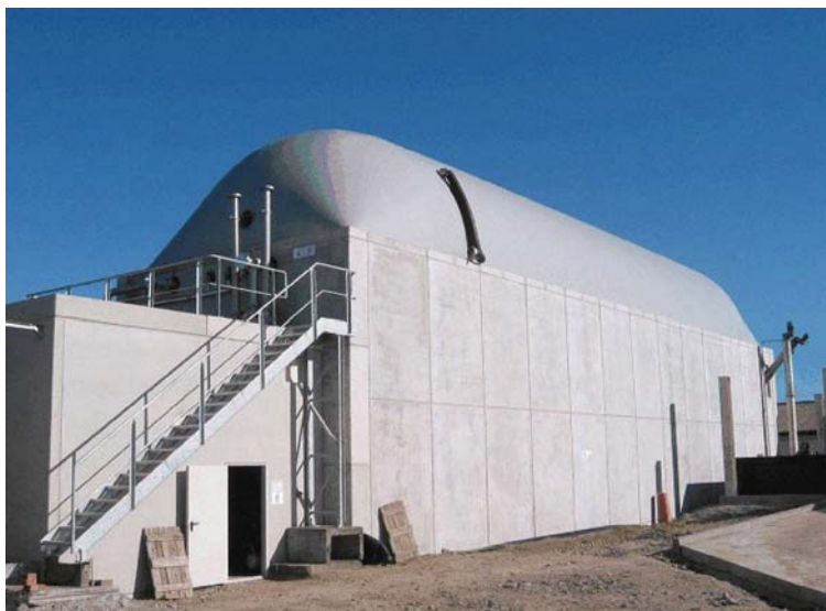
Objekt bioplynové stanice
