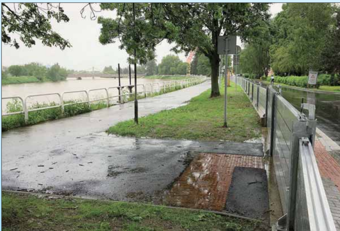
Obr. 4.16 Mobilní povodňové zábrany na Vltavě v Českých Budějovicích (foto Libor Sváček).
